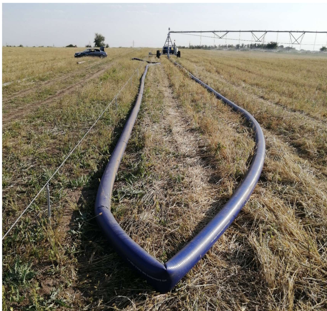
Рисунок 2.11 – Изгибы гибкого рукава в местах смены вектора направления движения его по траектории протаскивания
