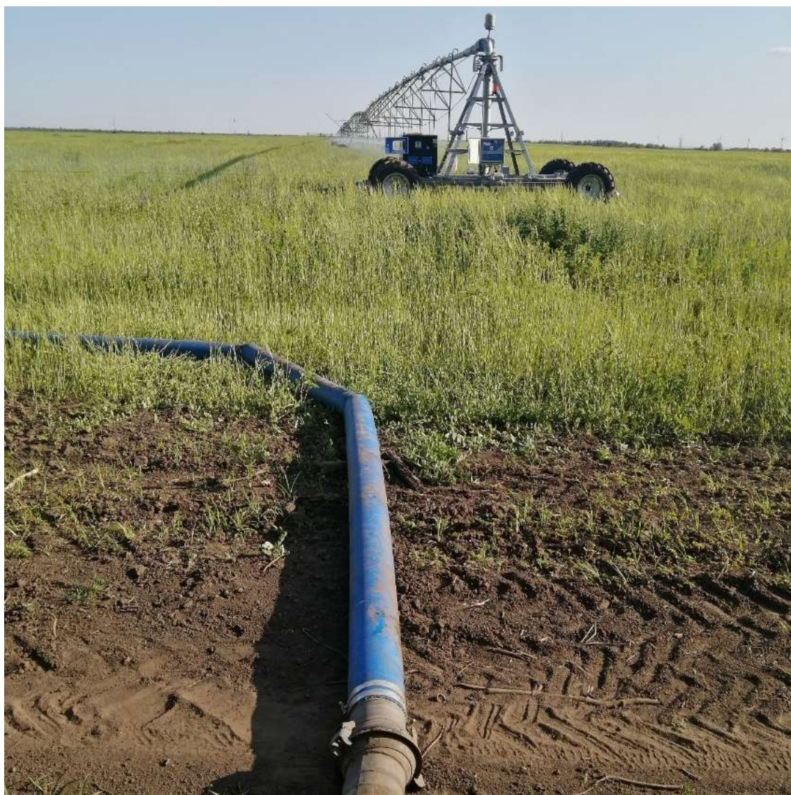
Рисунок 2.10 – Изгибы гибкого рукава в местах подключения к гидрантам оросительной сети
